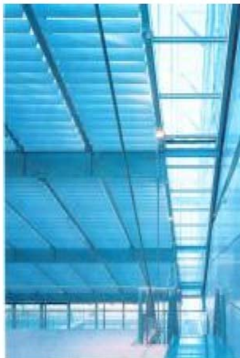
Lamelle fisse di alluminio riempite di lana minerale (Marne-la-Vallee, Scuola superiore)
